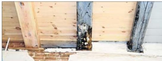
Blick zur Decke über der seitlichen Eingangstür: Neu neben Alt. Hier muss die Sanierung dringend fortgesetzt werden. Fotos: S. Tausche
