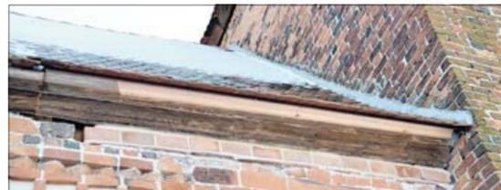
Etwa derselbe Bereich (Bild links) von außen: Zu erkennen ist die teilweise erneuerte Mauerlatte. Dies ist ringsum notwendig.
