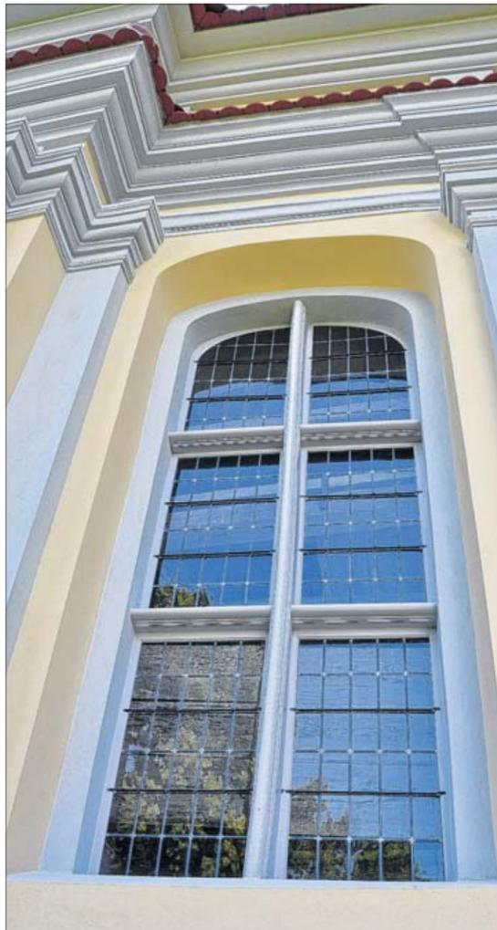
Prächtig fügen sich die restaurierten Fenster mit neuer Bleiverglasung in die sanierte, in frischen Farben strahlende Fassade ein. Die Fensterkreuze sind passend im gleichen Grauton gestrichen.
